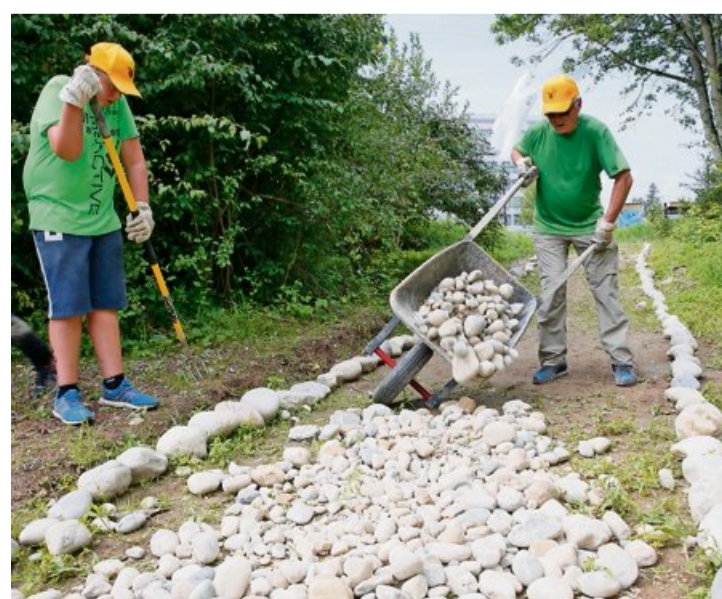
Sie legen Stein für Stein in den Weg durch den «Zauberwald». Wenn alle Steine gesetzt sind, wird ein Bagger diese noch in den Boden drücken.
