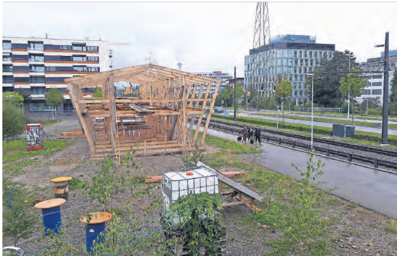
Noch steht erst der Rohbau des Holzpavillons auf der Brache.
